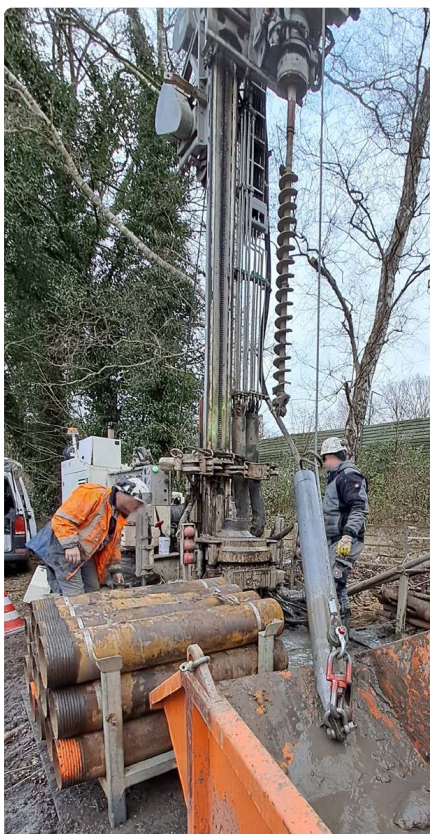
Aufbau einer Kernbohrung als Trockenbohrung
