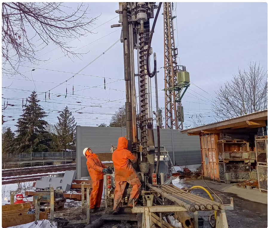
Einblick in den Boden Verdens: Bohrarbeiten im Januar 2024
