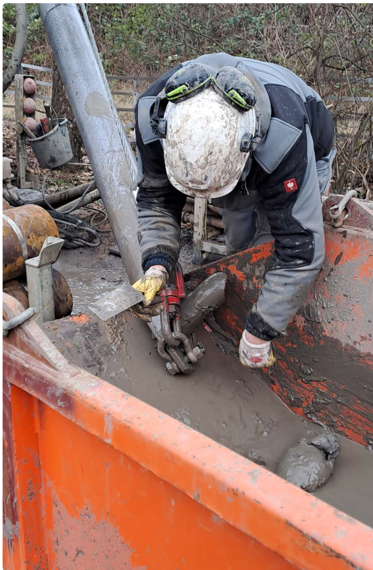
Entfernung von überschüssigem Bodenmaterial aus dem Bohrer
